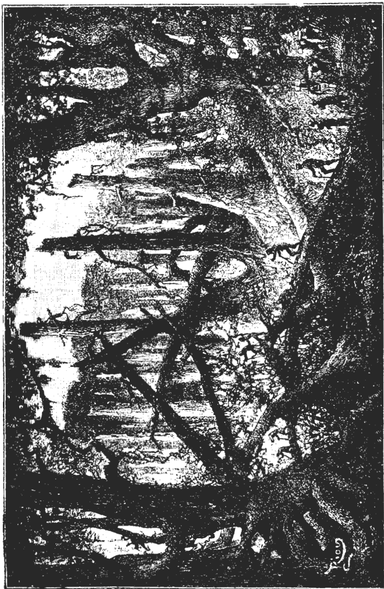
Прокладка пути по лѣсу.
